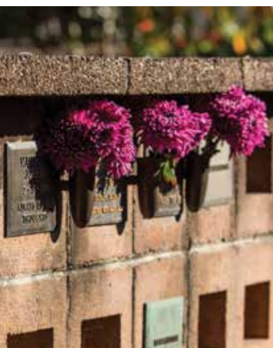
Una nicchia a muro nel cimitero di Burwood
